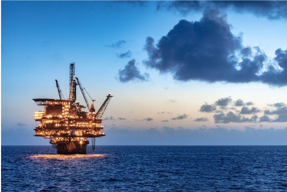
Shell Perdido Platform—May 2018
